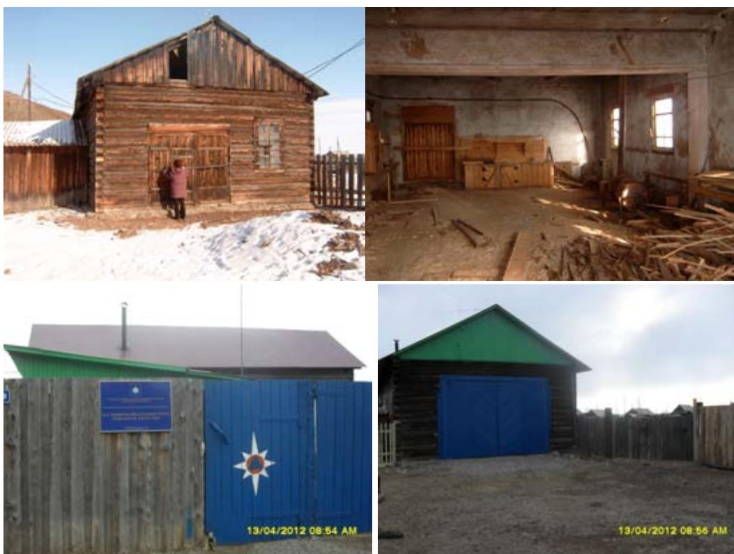
Фото: Пожарная часть № 80 с. Байкальское до и после ремонта.
