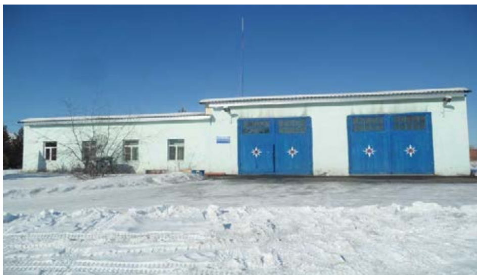
Фото: Здание Пожарной части №49 п.Новый-Уоян
