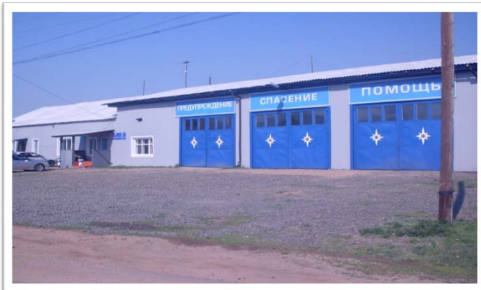
Фото: Здание ПЧ № 60, 2015 г
